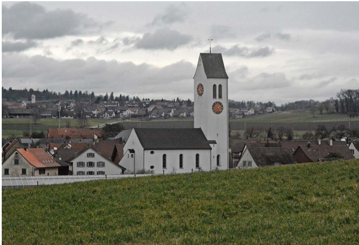
Seltenheit: Die Kirche Ossingen steht innen und aussen vollständig unter Denkmalschutz.
